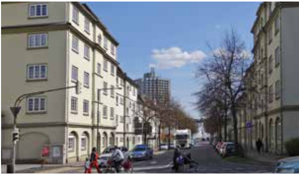
Sanierung im Rahmen von EU-GUGLE: Städtische Liegenschaft Joseph-von-Görres-Straße
