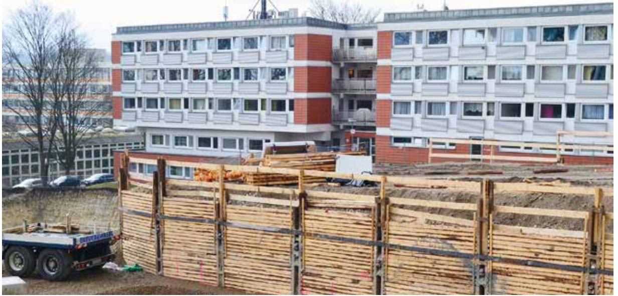
Anlage des Studentenwerks Aachen: Baustelle des Wohnheims Hainbuchenstraße
