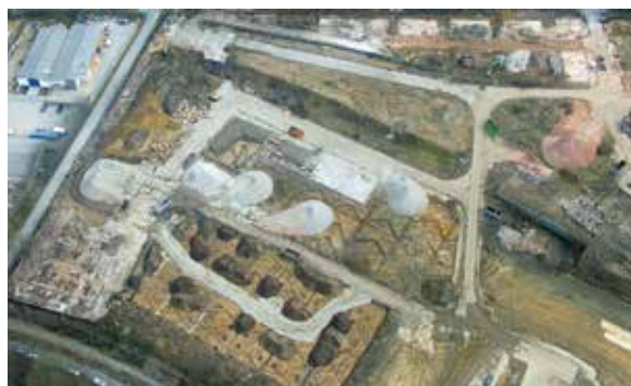
Schlackensanierung im nördlichen Grundstücksteil (separierte Schlackemieten, sanierte Drainagegräben, Mieten aus Recyclingbaustoffen)
