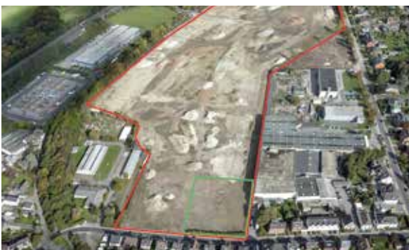
Oktober 2012: Camp Pirotte nach Abschluss der Abbruch- und Sanierungsmaßnahmen (grün Teilfläche Niessen)
