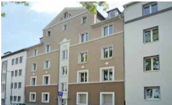
Liegenschaft Kühlwetterstraße nach Modernisierung
