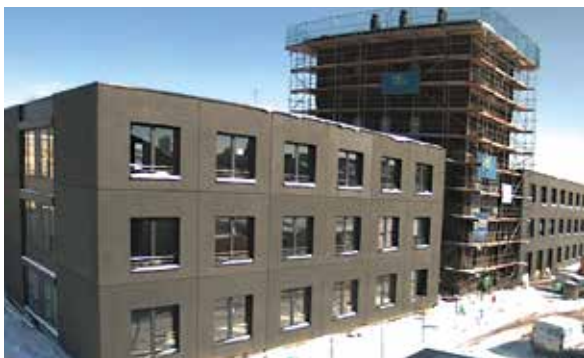
Integration in einen Bürokomplex: der denkmalgeschützte Kraftversorgungsturm (Foto: P3)
