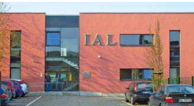
Neubau Fa. IAL, Metzgerstraße
