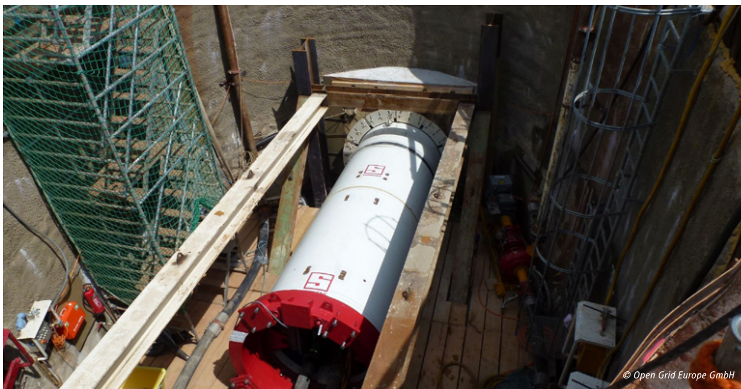
Startgrube zur Untertunnelung des Brander Walls
